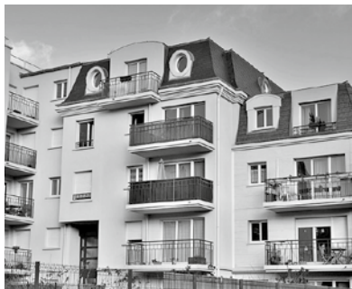
un appartement dans un immeuble récent
