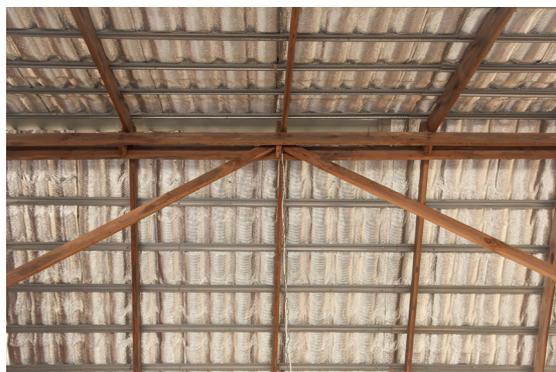
Isolation en aluminium d'une toiture.
